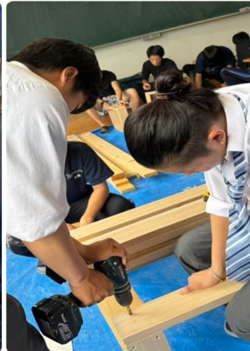
組み立てる 電動ドリルで部材を固定していく
