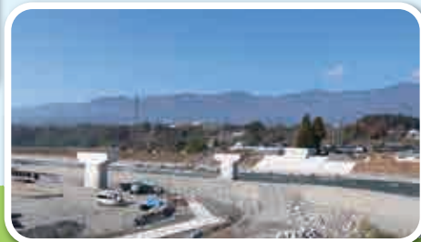
完成が待ち遠しい新宮ヶ瀬橋
