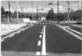
町道 大草線(元大島) 完成
