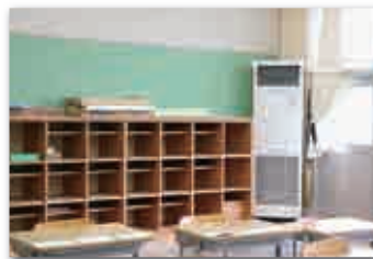
小・中学校にエアコン設置
