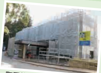
町民体育館 耐震工事始まる
