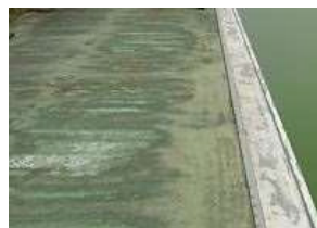
⑤プールサイド改修
