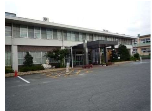
現況写真(正面玄関側より)
