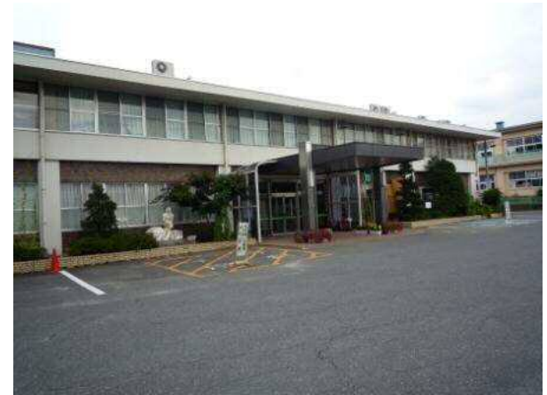
現況写真(正面玄関側より)
