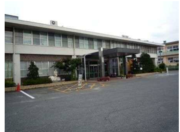
現況写真(正面玄関側より)
