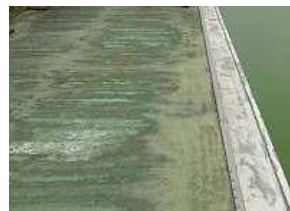
⑤プールサイド改修
