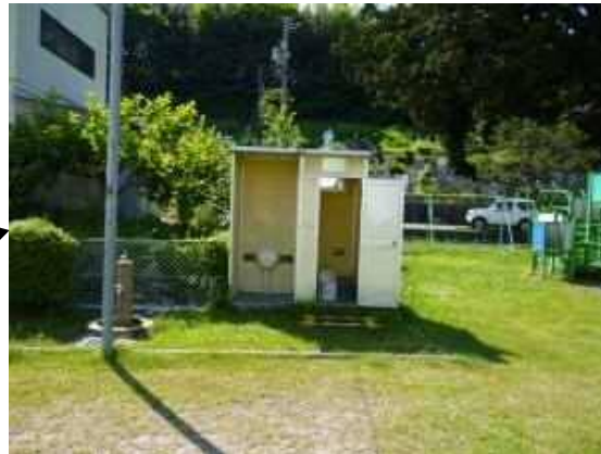
整備箇所の現況
