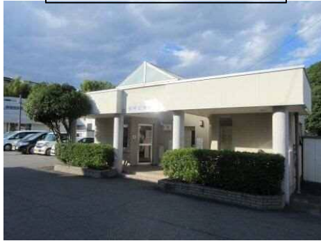
整備箇所の現況①
