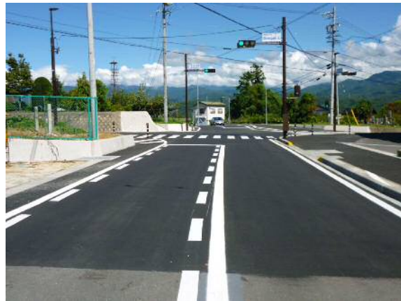
大草線 道路改良工事
