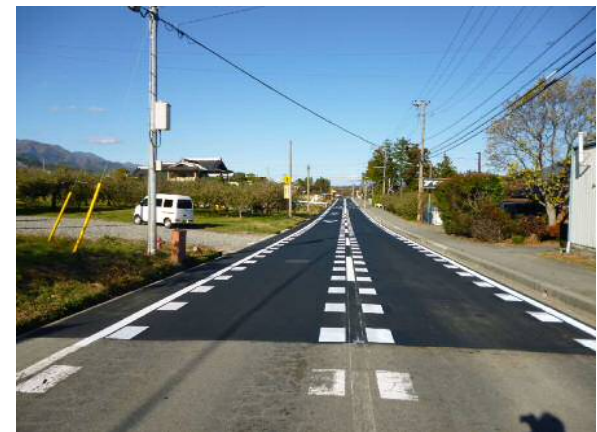
東原線 舗装補修工事
