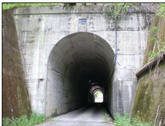
写真 2-2 柄山トンネル
