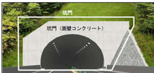
図 2-9 トンネル坑口部の点検対象箇所
