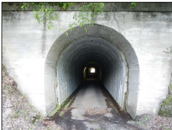
写真 2-1 深田トンネル
