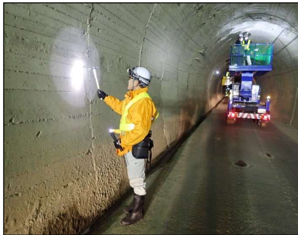
写真 2-4 徒歩によるトンネル点検の様子
