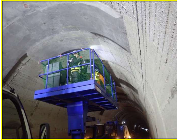
写真 2-3 高所作業者によるトンネル点検の様子
