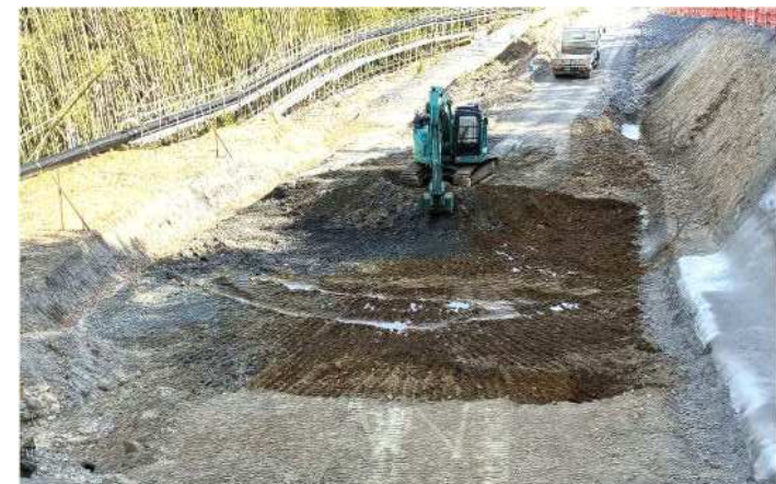
施工箇所の基礎部掘削状況
