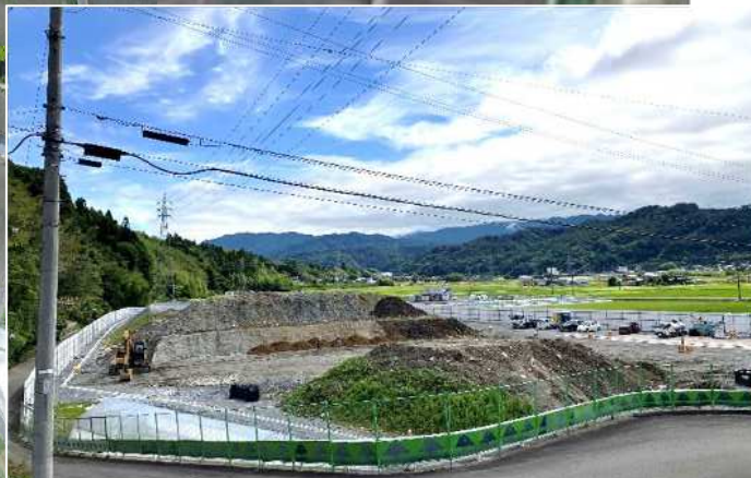
資材ヤードの状況
