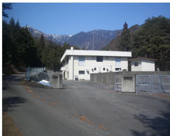
松川町 中桐浄水場
