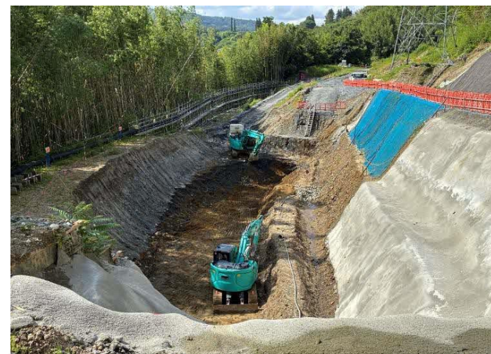
施工箇所の基礎部掘削状況
