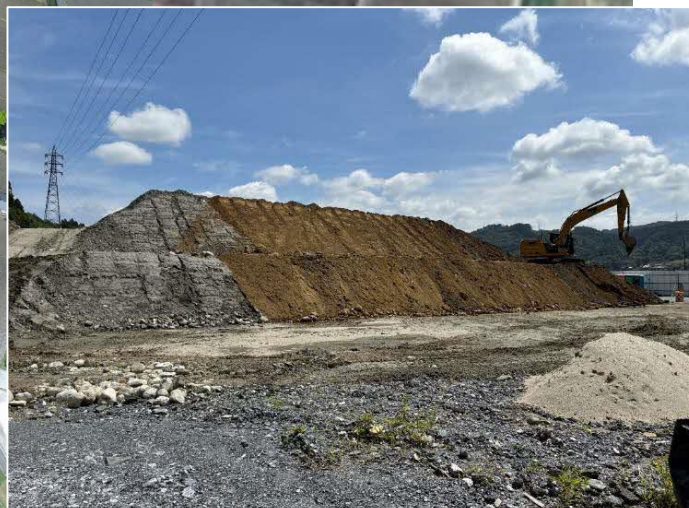
資材ヤードの状況
