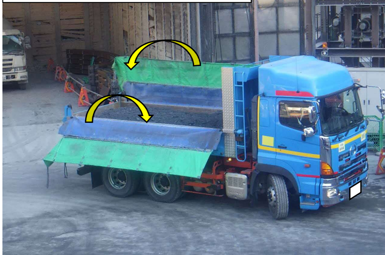
防塵シート敷設作業状況
