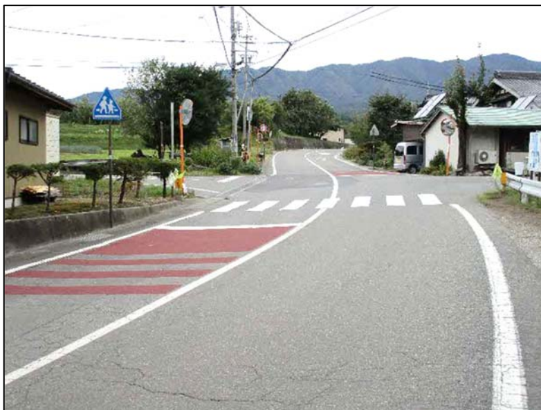
古町境の沢線と神護原線交差点 横断歩道復旧とカラー舗装
