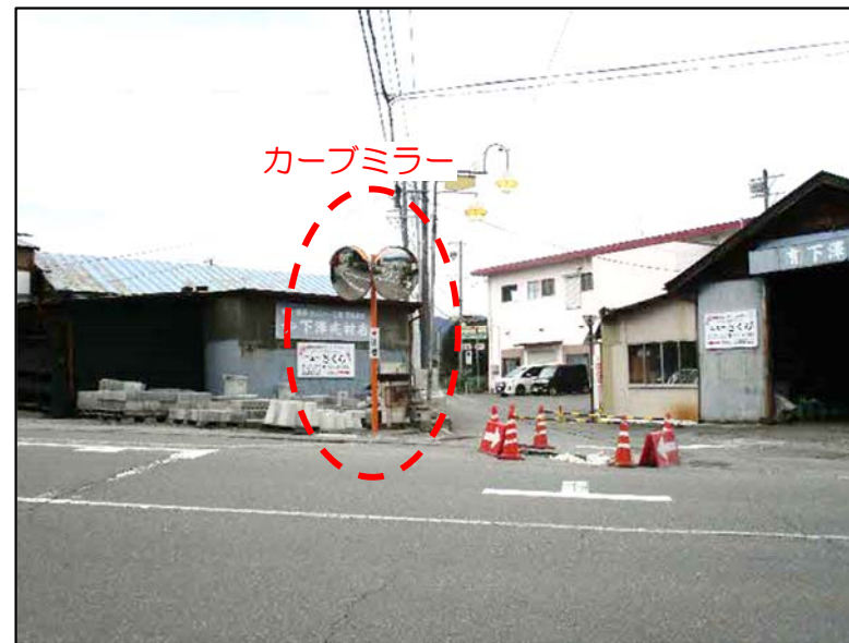
松川インター大鹿線と神護原線交差点 カーブミラー更新
