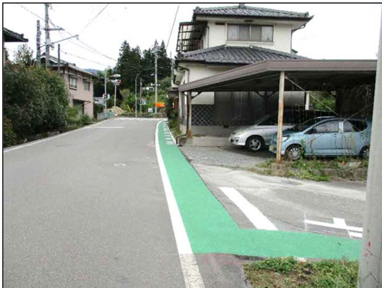
鶴部線鶴部信号付近 側溝整備とカラー舗装(グリーンベルト)
