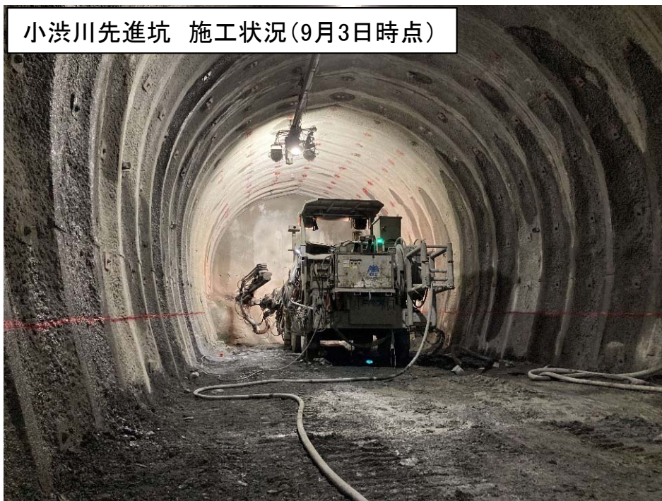
小渋川先進坑 坑内状況(9月3日時点)
