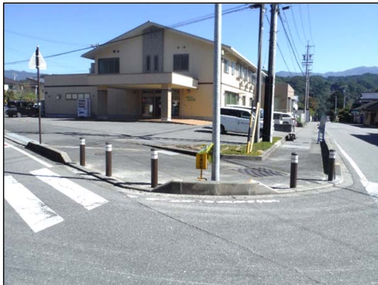
松川インター大鹿線(七楯神社前) 車止めポストの設置(キングポスト)
