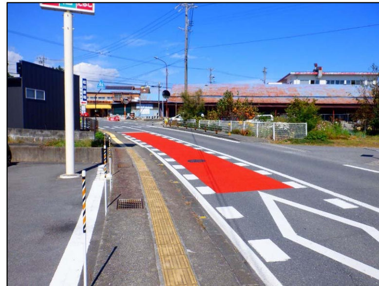
松川インター大鹿線と神護原線交差点 カラー舗装
