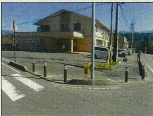
松川インター大鹿線(七楯神社前) 車止めポストの設置(キングポスト)
