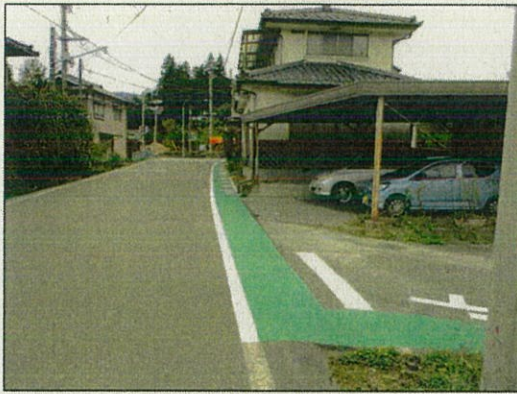
鶴部線鶴部信号付近 側溝整備とカラー舗装(グリーンベルト)
