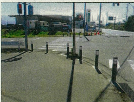
松川インター大鹿線(東浦交差点) 車止めポストの設置(キングポスト)
