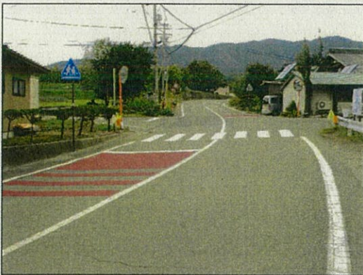
古町境の沢線と神護原線交差点 横断歩道復旧とカラー舗装
