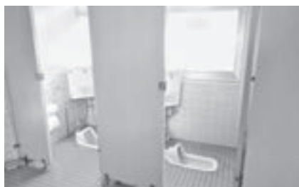
小中学校 洋式トイレに改修
