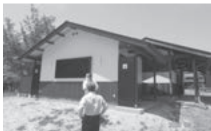
新設されたシャワー室
