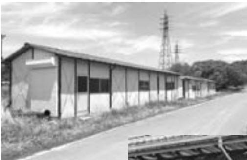
水防資材倉庫移設
