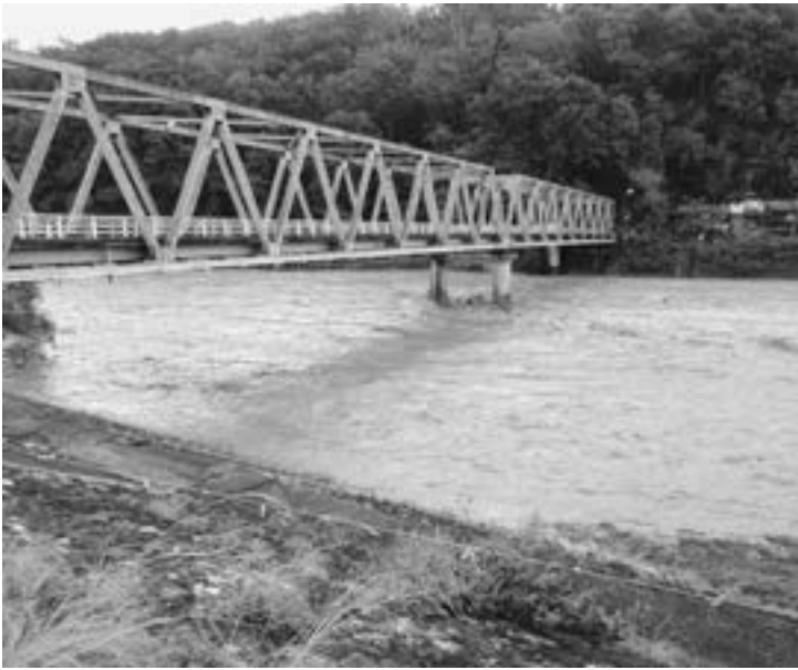
増水した天竜川宮ヶ瀬橋
