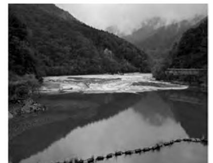
堆積土が目立つダム湖上流
