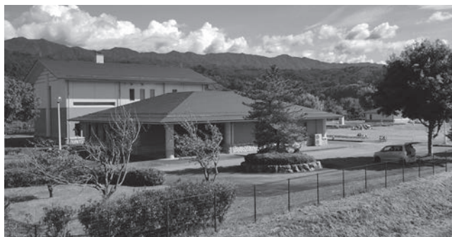
前河原の公共下水浄化センター
