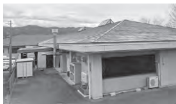
屋根を修繕予定の 社会福祉センター
