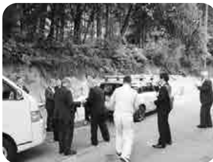
進む229号線改良工事
