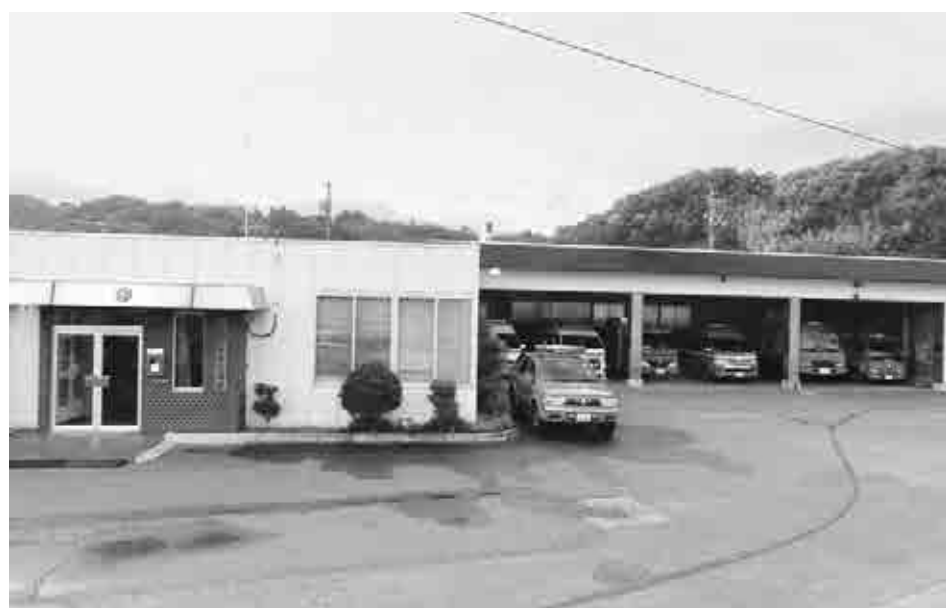
老朽化と冠水の危険
