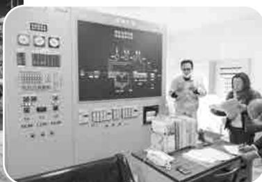
浄水場監視システム機器の更新
