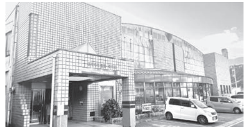
屋根、壁の改修が決まった松川町図書館
