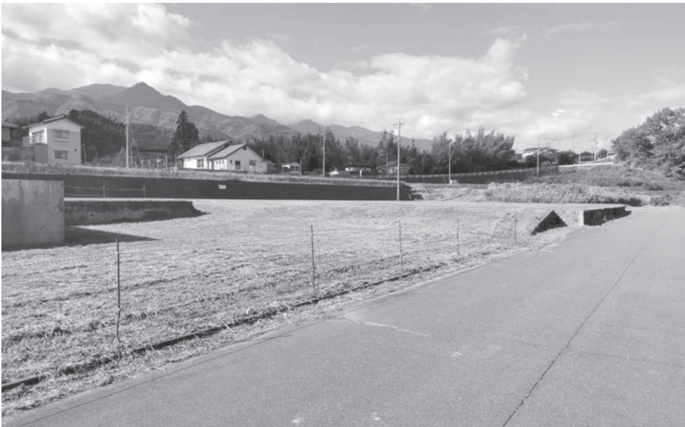
早期活用に期待、上片桐専用側線跡地
