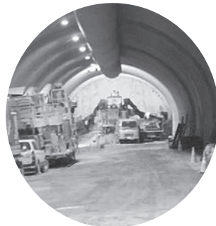
5月26日に貫通した青崩トンネル
