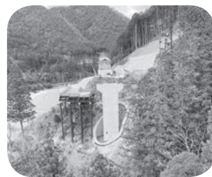
三遠道路8号橋
