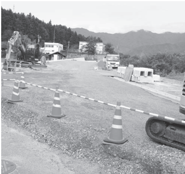
進む洞進線 新設道路工事
