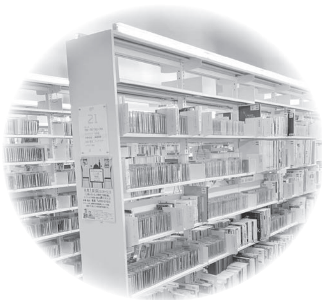
本棚の上にLEDが設置され明るさに工夫(塩尻図書館)
