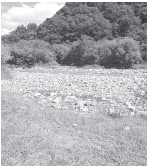
部奈橋の架かっていた場所 町道ではない?先ずは町道認定が先か
