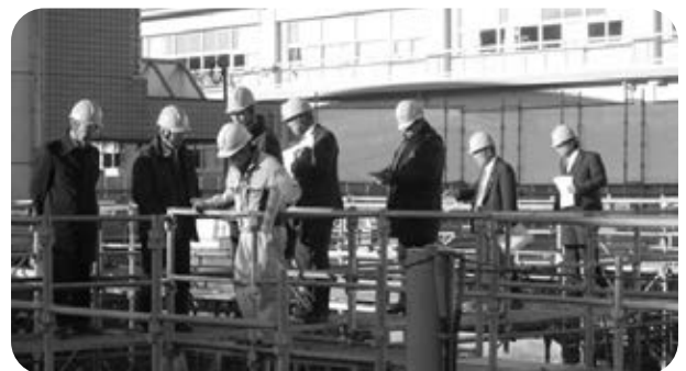
新公民館の基礎工事は大丈夫か
