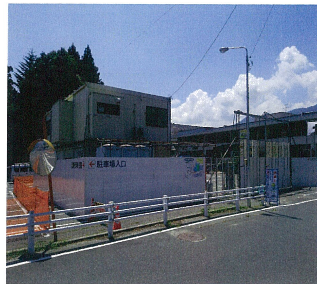
NO. 2 仮設事務所・仮囲い0722~0726 2015-08-05
