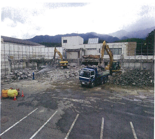
NO. 10 上屋躯体解体0831 2015-08-31
