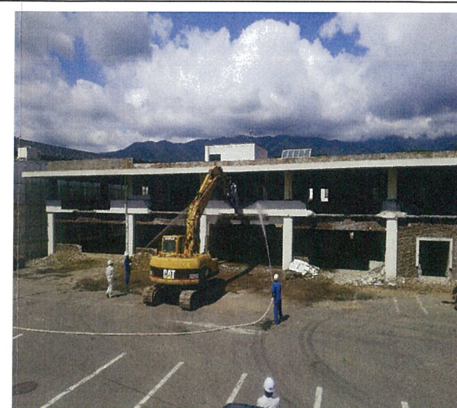
NO. 8 上屋躯体解体0824 2015-08-24
