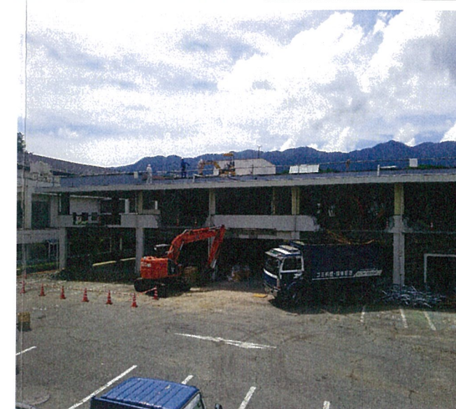
NO. 4 内外装解体0803~0822 2015-08-18
