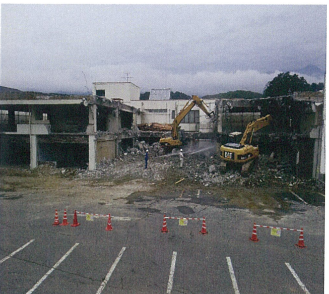
NO. 9 上屋躯体解体0825 2015-08-25
