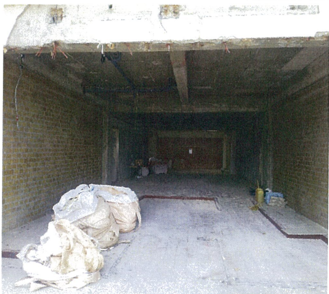
NO. 5 1Fエントランス内装解体状況0818 2015-08-18
