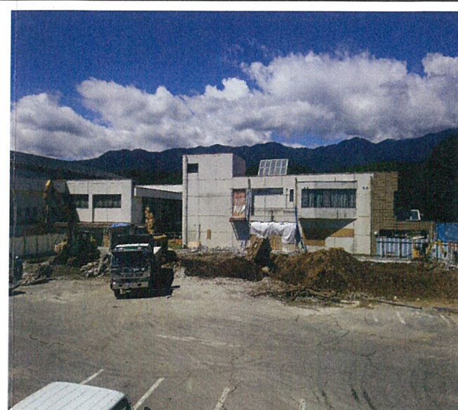
NO. 12 基礎躯体解体0911 2015-09-11
