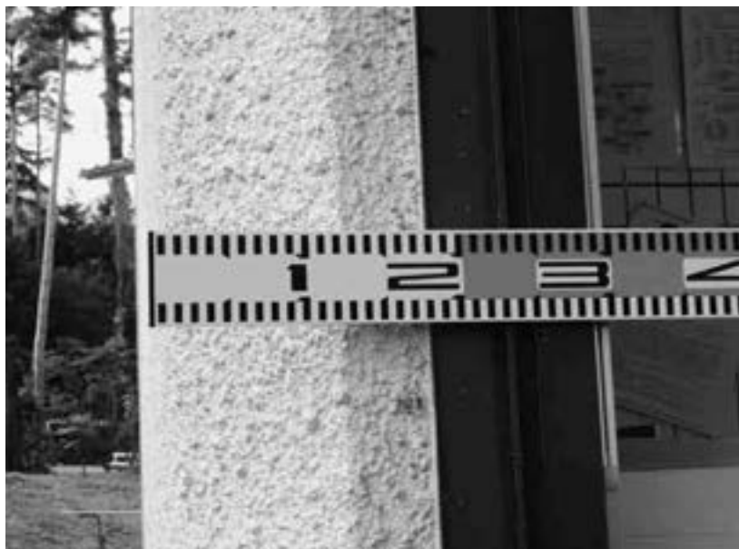
300ミリの堅固な躯体の壁厚
