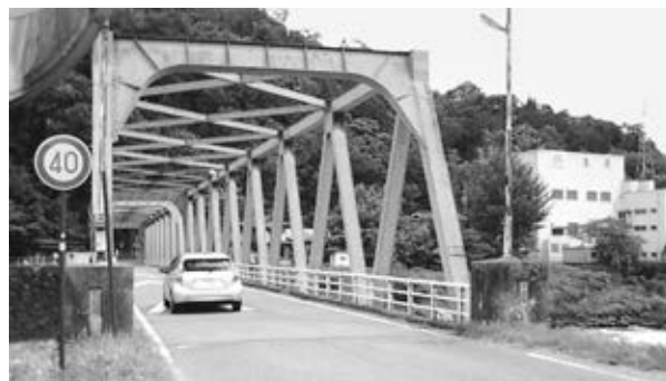
現在の宮ヶ瀬橋
