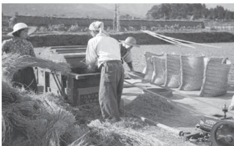
昭和30年代の脱穀作業の光景です。動力源が足踏みから発動機となり平ベルトをかけて脱穀機を回し脱穀しています。ベルトの空滑りを無くするため、固形の松やにを塗っていた事を思い出します。モミが入った「かます」が並んでいます。はざから稲を運ぶのも大変で家族や結んで来てくれた人達による脱穀作業でした。
