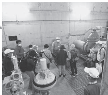
地下には大切な装置
