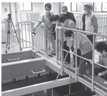
足の下は全て沈殿池
