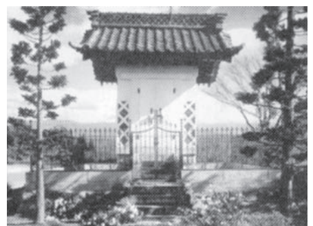
大正4年、竣工時の奉安殿
