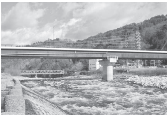
令和3年 新宮ヶ瀬橋
