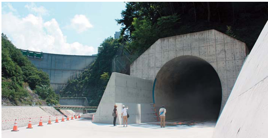
小渋ダムの下流に完成した4kmにもわたる土砂バイパス
