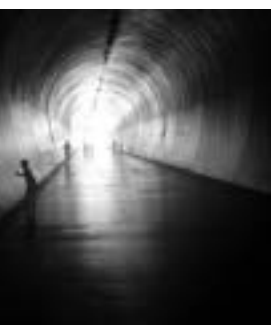
排砂トンネル
