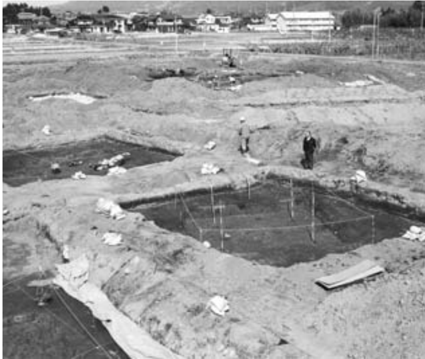
調査が終わると保育園建設が始まる
