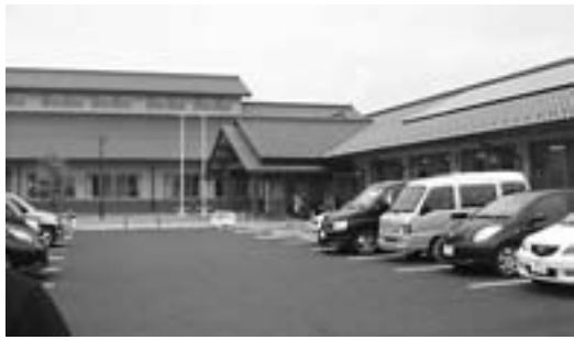
平屋建て。蚕室づくりをイメージした外観
