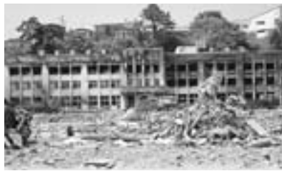
津波と火事の被害を受けた学校 高台の家は無事でした
