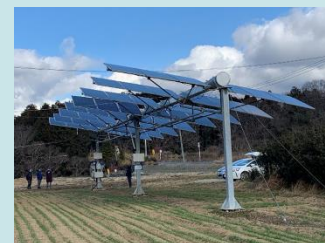
太陽に自動追従など角度が2軸で変えられます。
