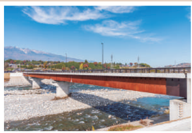
新宮ヶ瀬橋完成
