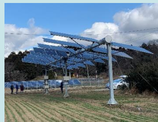
太陽に自動追従など角度が2軸で変えられます。
