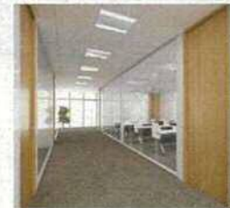
活動室と廊下の壁は木製 方立てガラススクリーン
